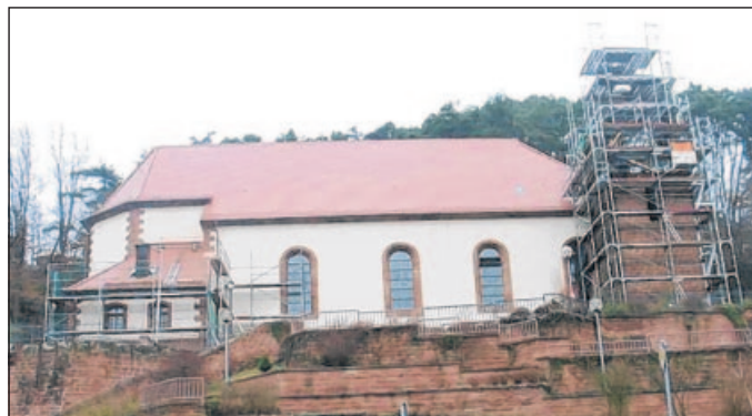
Dach neu, Turmhelm fehlt – noch. —FOTO: DANNER
